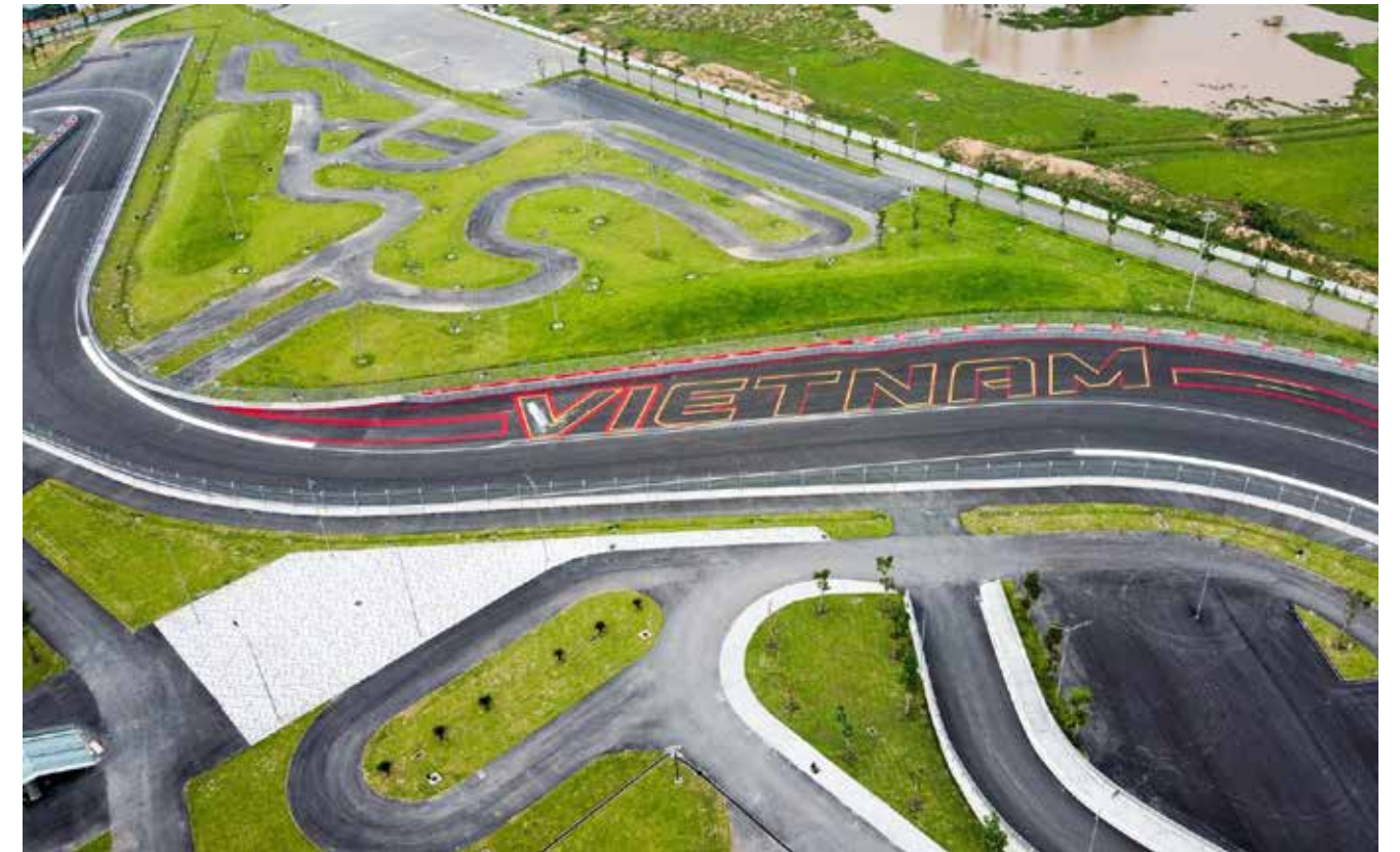
XÂY DỰNG PHẦN KHU 1 - CÔNG VIÊN CÂY XANH KẾT HỢP MỘT SỐ CÔNG TRÌNH PHỤ TRỢ PHỤC VỤ GIẢI ĐUA XE CÔNG THỨC 1
