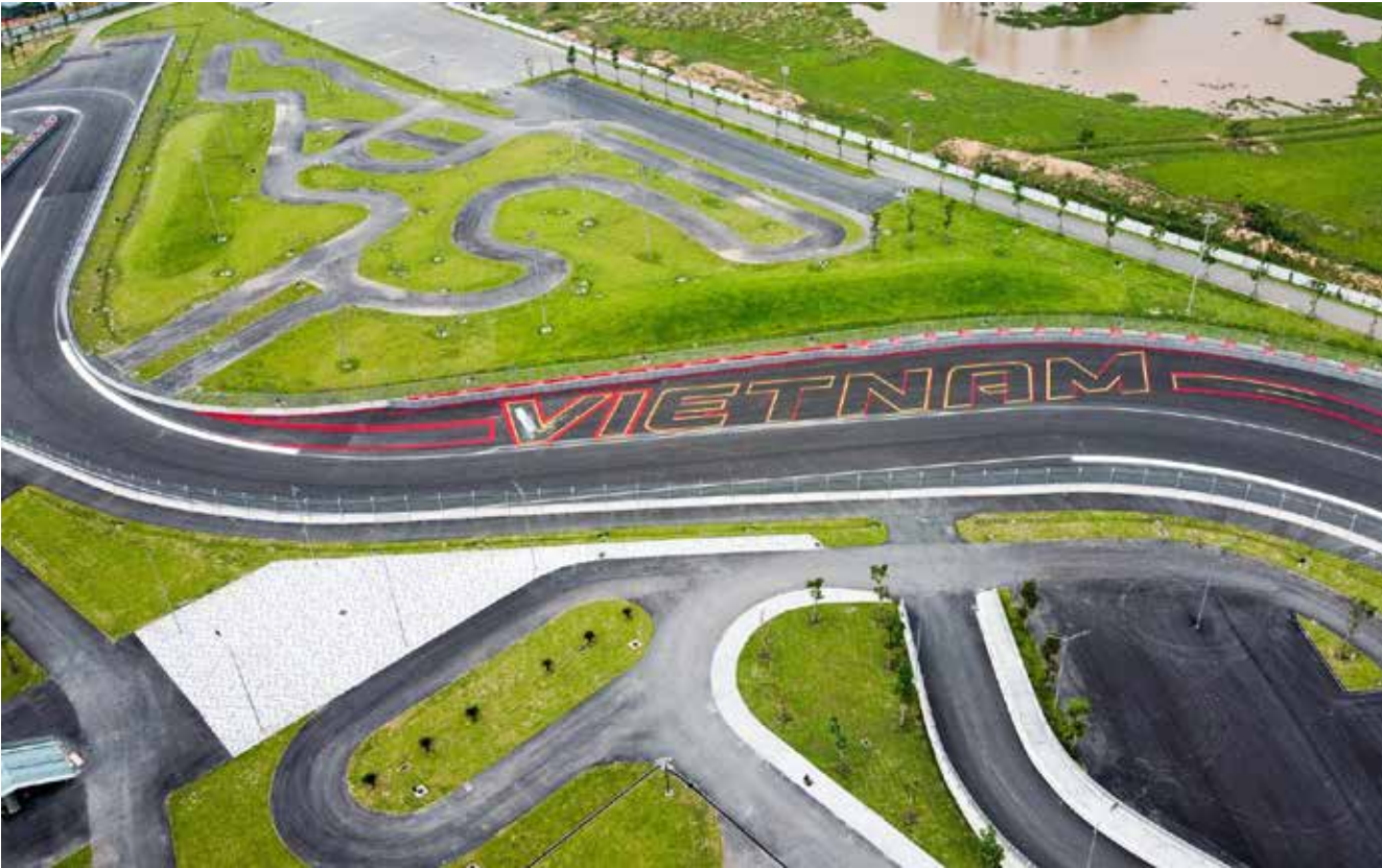
XÂY DỰNG PHÂN KHU 1 - CÔNG VIÊN CÂY XANH KẾT HỢP MỘT SỐ CÔNG TRÌNH PHỤ TRỢ PHỤC VỤ GIẢI ĐUA XE CÔNG THỨC 1 Địa điểm xây dựng: TP. Hà Nội Chủ đầu tư: Công ty TNHH Việt Nam GRAND PRIX Thời gian thực hiện: 2019 Dịch vụ cung cấp: Tư vấn quản lý dự án; Tư vấn giám sát
