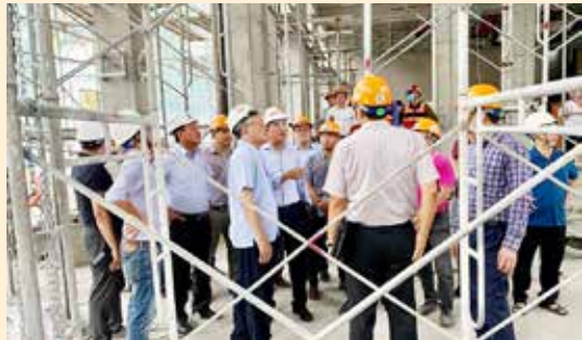
Ủy viên Bộ Chính trị - Chánh án Tòa án NDTC Nguyễn Hòa Bình và đoàn lãnh đạo Bộ Xây dựng kiểm tra công trường xây dựng trụ sở TAND tối cao
