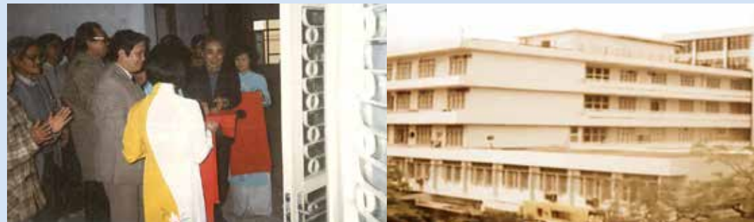
Khai trương khối nhà làm việc 5 tầng của Công ty tại số 4 Tôn Thất Tùng
