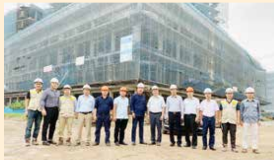
Lãnh đạo Công ty kiểm tra dự án Học viện Chính sách và phát triển
