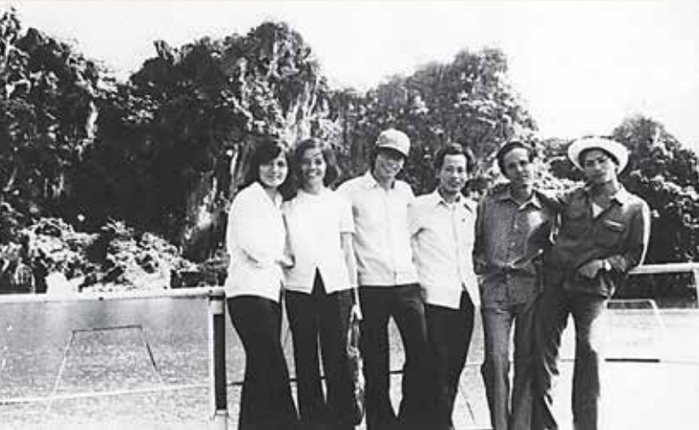
Cán bộ của viện đi khảo sát thực tế tại công trình Nhà máy sửa chữa Tàu biển Phà Rừng
